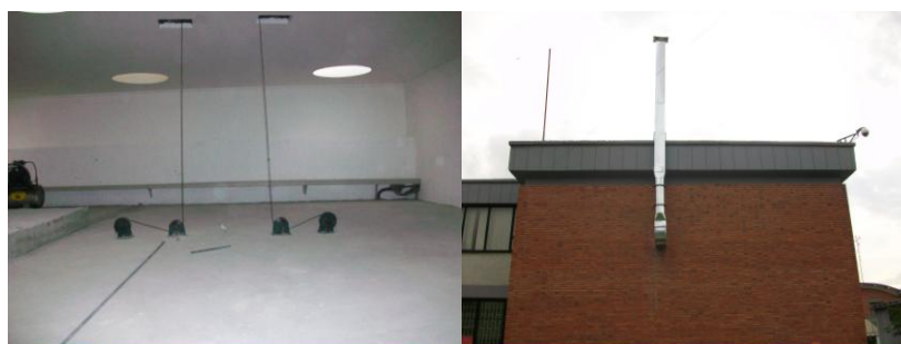
Figura 82. Obras del mejoramiento del blindaje en la losa intermedia de la Planta de Irradiación Gamma.
