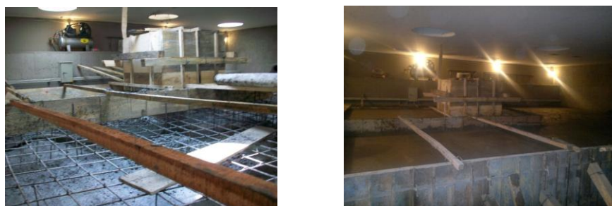
Figura 81. Obras del mejoramiento del blindaje en la losa intermedia de la Planta de Irradiación Gamma
