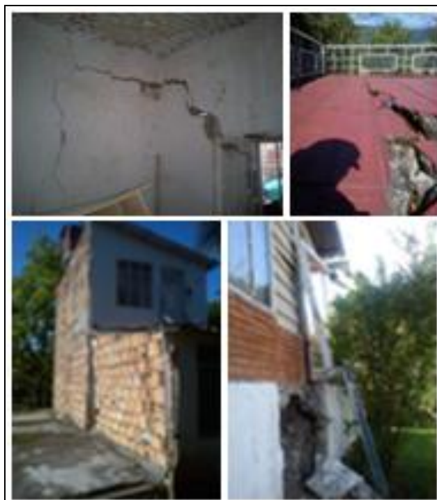
Figura 40. Afectación de viviendas del barrio San Jorge en Villeta, Cundinamarca.
