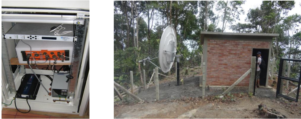
Figura 76. Equipos y casetas para la actualización del Sistema Sismológico y Vulcanológico de Colombia.
