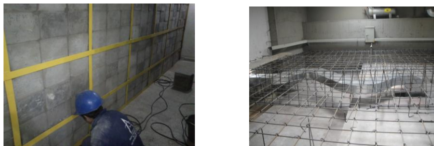
Figura 80. Obras del mejoramiento del blindaje en la sala de irradiación y losa intermedia de la instalación.
