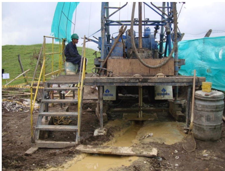
Figura 21. Perforación exploratoria en la finca Bombonera, sector intermedio del Sistema Acuífero Abanico del Quindío.
